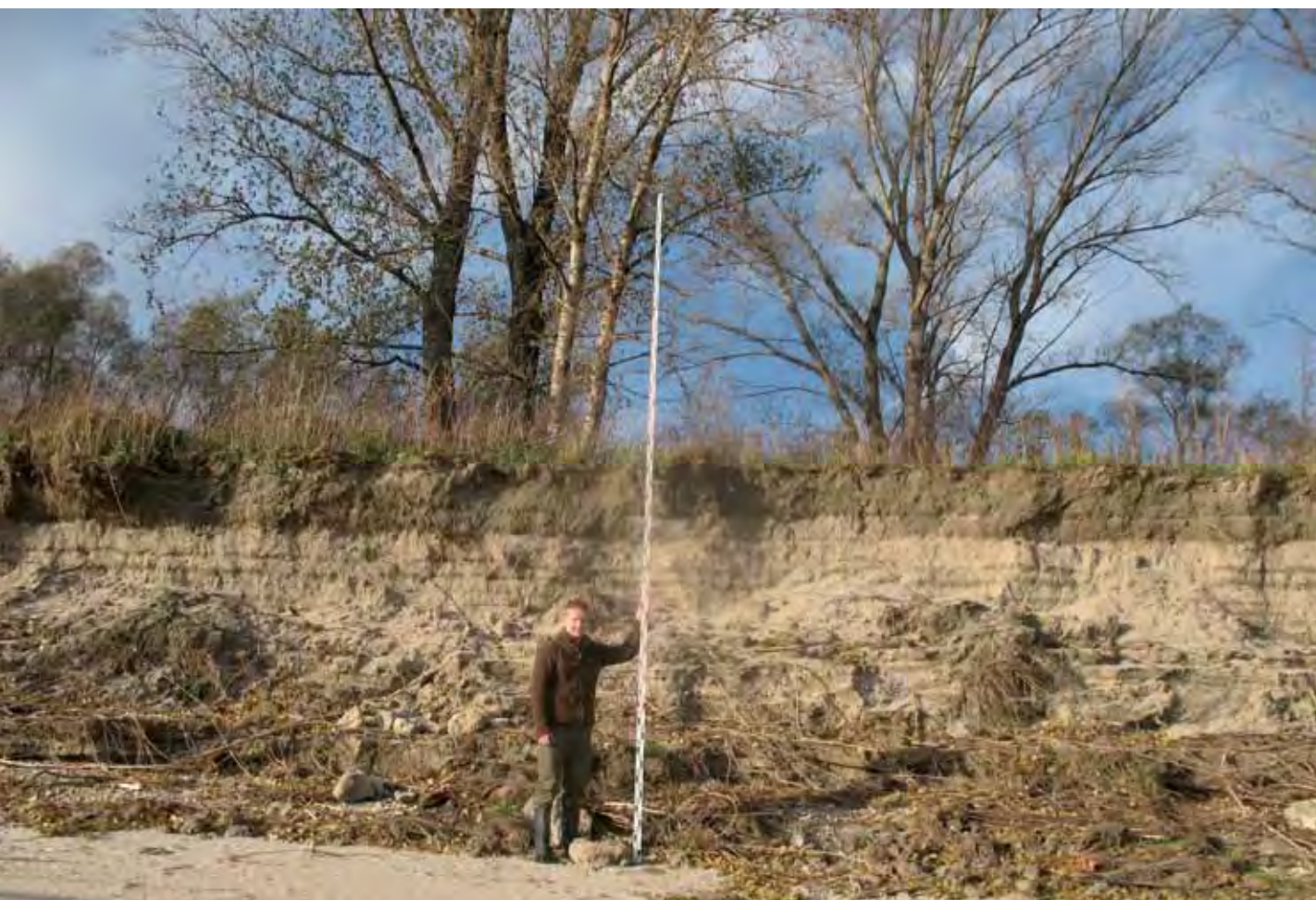
Vermessung der mächtigen Uferanrisse, die durch den Uferrückbau am Thurnhaufen initiiert wurden. (Foto: Katrin Rätzsch)
