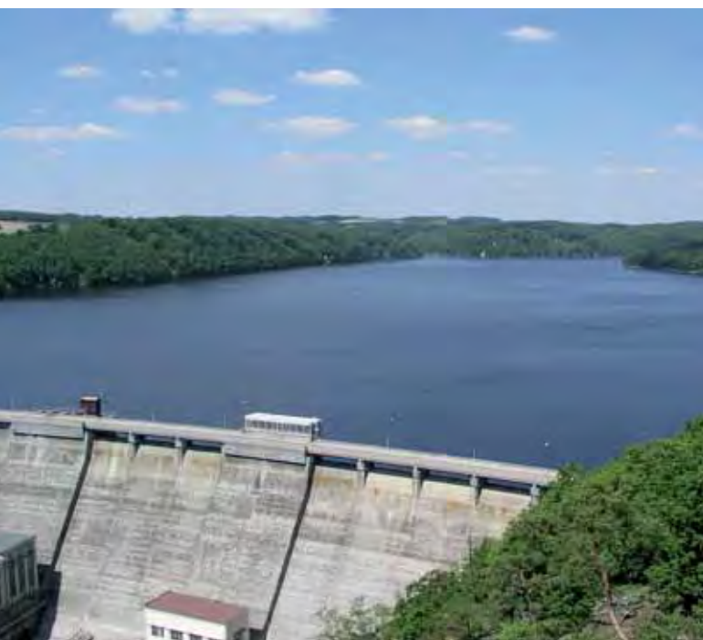
Kraftwerk Vranov (Frain) (NP Thayatal)
