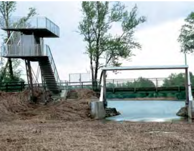
Seit dem Umbau der Gänshaufentraverse – hier mit geöffneter Wehranlage – und der dadurch verbesserten Durchgängigkeit hat sich die Anzahl der Fischarten im Kühwörther Wasser deutlich erhöht. (Foto: H. Dolecek)
