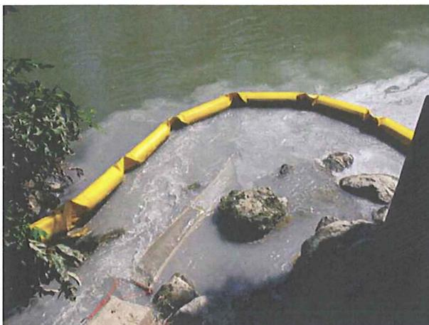
Abbildung 2.: Der Standort Kanal, Mündungsbereich in die Fischa mit flotierender Sperre zum Rückhalt von eingeschwemmten Plastikpartikeln
