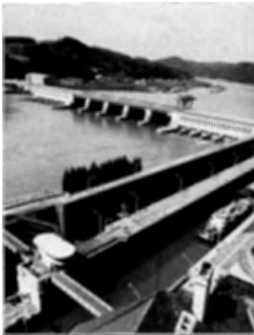
Abb. 1. Kraftwerk Ybbs-Persenbeug: Hauptbauwerk in der Bau- und Betriebsrichtung Oberwasser
