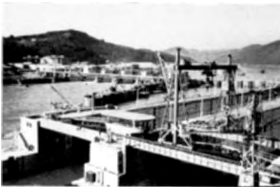
Abb. 3. Kraftwerk Ybbs-Persenbeug; Generalansicht vom linken Ufer-Unterwasser mit Fertigstellung der Baugrube (Zellenfangdamm) für das Nordkraftwerk
