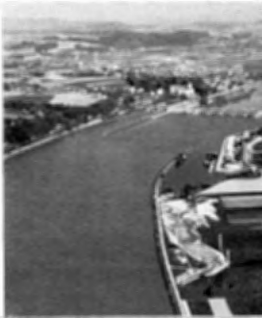
Abb. 18. Kraftwerk Ybbs-Persenbeug; Gesamtan
