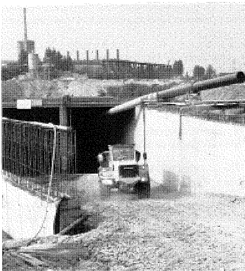
Abb. 25. Südlicher Stollenmund des Sammel Hintergrund die Anlage der VOEST mit dem Kraftwerk
