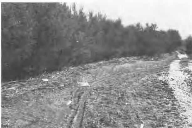
Abb. 3. Bremspflanzung im Bereich der Überströmstrecke Kraftwerk Wallsee-Mitterkirchen, linkes Ufer
