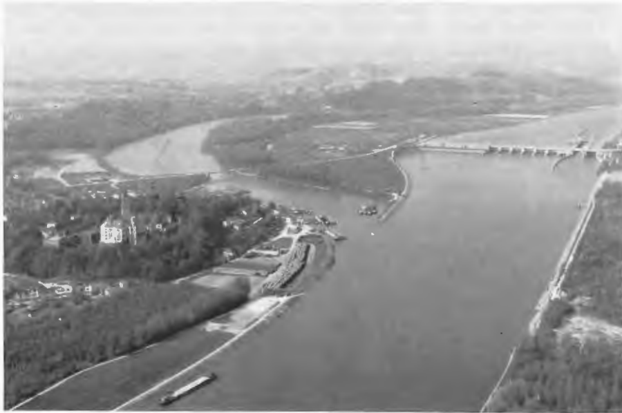
Abb. 12. Kraftwerk Wallsee-Mitterkirchen: Luftaufnahme von Hauptbauwerk und Altarm, Blickrichtung Oberwasser, 14 Jahre nach Inbetriebnahme (BMfLV, Zl. 13080/176-1.6./82)
