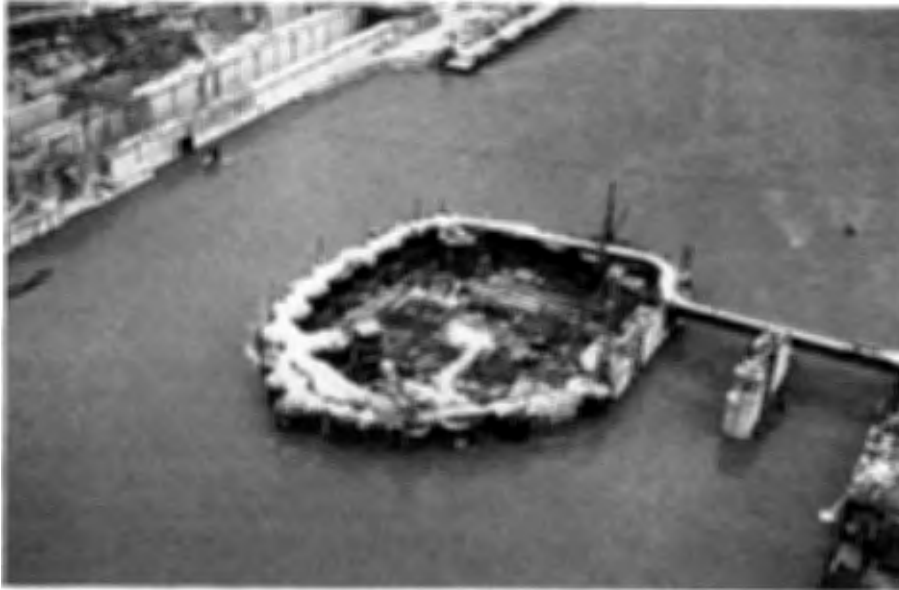
Abb. 2. Kraftwerk Ybbs-Persenbeug; Inselbaugrube für die Errichtung der Wehrfelder (BMfLV – 34482-LA/56)
