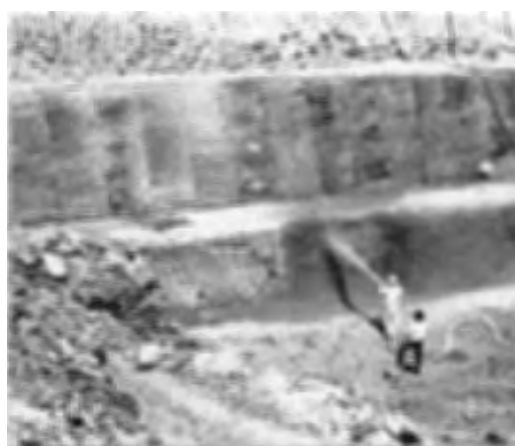
Abb. 10. Schlieraushub mit Spritzbetonsicherung
