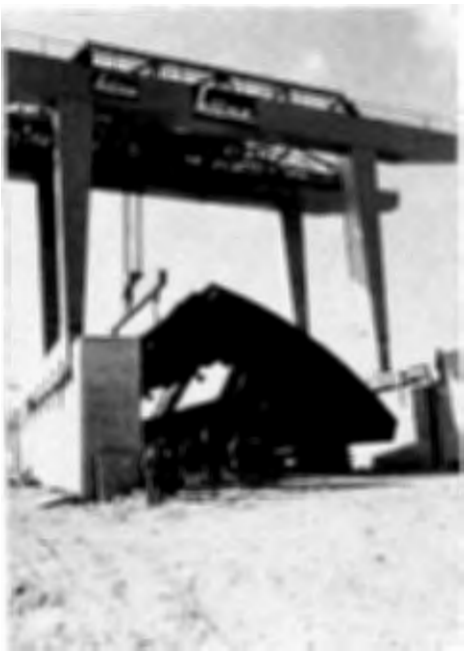
Abb. 16. Kraftwerk Altenwörth; Drucksegment in
