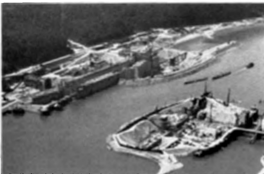
Abb. 5. Kraftwerk Aschach; Luftaufnahme der Baugrube Abschnitt Ia mit Schiffsöffnungsöffnung (BMfLV, Zl. 318615/Luft/III/61)
