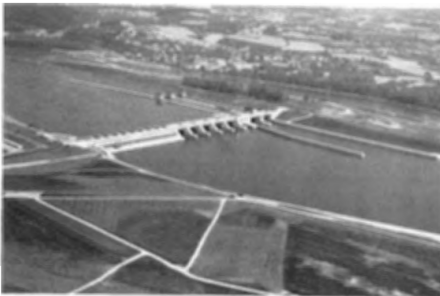
Abb. 10. Kraftwerk Abwinden-Asten : Luftaufnahme des Hauptbauwerkes drei Jahre nach Bauerrichtung, Blickrichtung Oberwasser, im Hintergrund der Donauarm (BMfLV, Zl. 13080/176-1.6./82)
