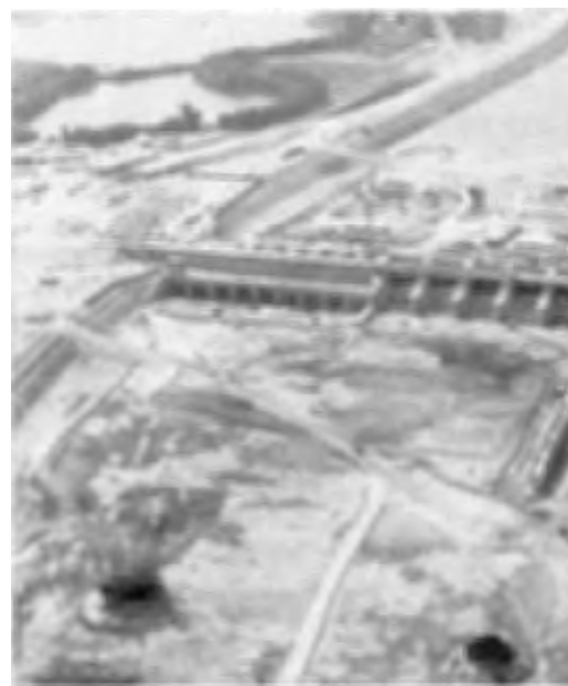
Abb. 11. Kraftwerk Abwinden-Asten; Bauzustand
