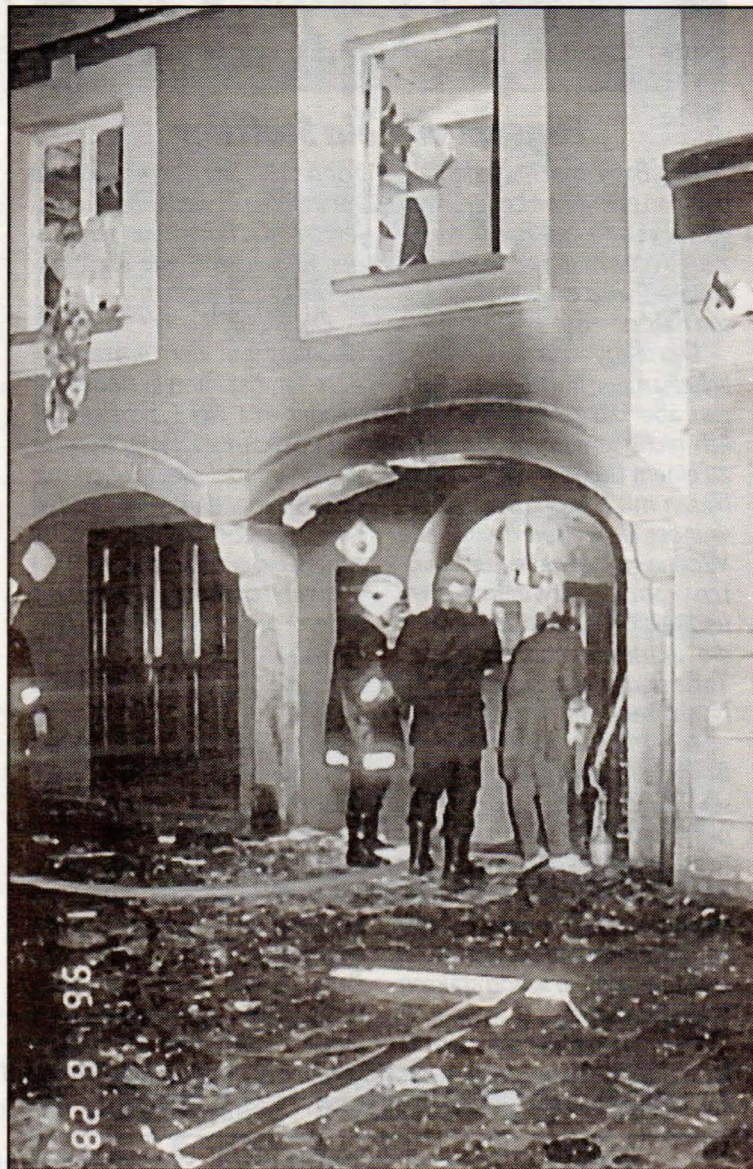
▲ Durch die Explosion wurde dieses Haus in der Linzer Altstadt völlig zerstört – es muß abgerissen werden. Zu dem Unglück war es ▲ durch einen Glimmbrand unter dieser Gasleitung gekommen (l.).
