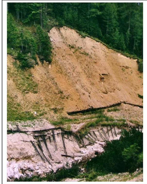
**Abbildungen 36, 37:** Sohlstabilisierungsmaßnahmen und Hangsicherungsmaßnahmen im Kühgraben (Foto: Ehrenfeldner, 2001)
