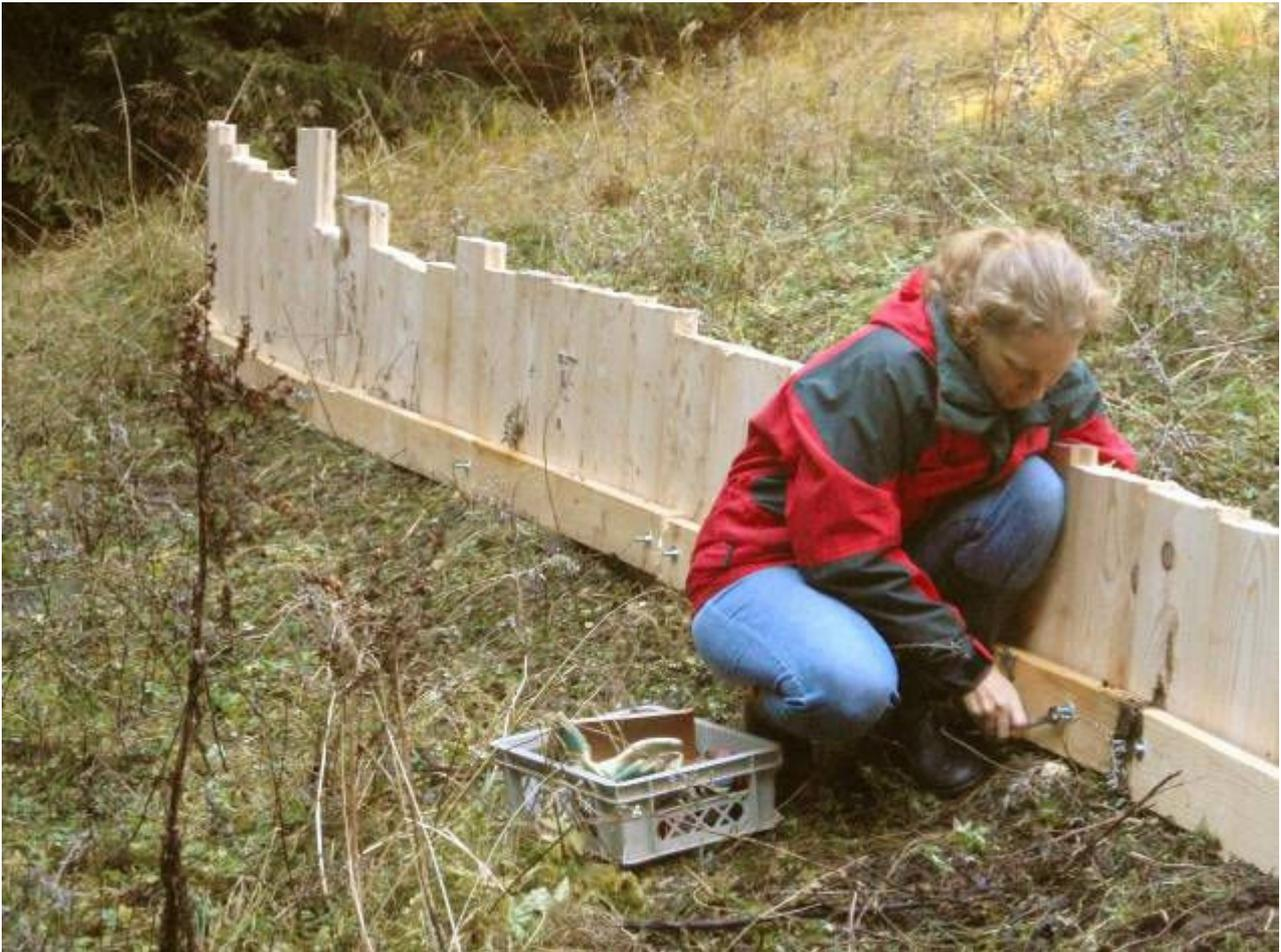
Abb. 8 | Montage des Führungsbalkens an der langen Spundwand, damit die Verdämmung unter Schnee- und Frosteinwirkung und bei Nässe nicht aufklafft (oben und unten links). Anschließend werden die Bohlen in Höhe der Führung abgesägt (unten Mitte). Unten rechts: Verspundung des tiefen Drainagegrabens. | Fotos: H. Haseke
