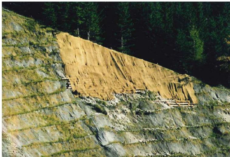
Abb. 22: Begrünung mit Geotextil (FOTO: WLV Unteres Ennstal und Salzatal, 1999)
