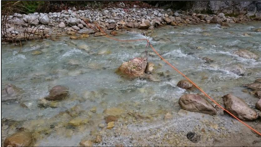
Abb. 23: Führung des Kabels über das Wasser und Verbindung mit Gesteinsblock im Fluss (Quelle: Eigene Aufnahme, 2015)
