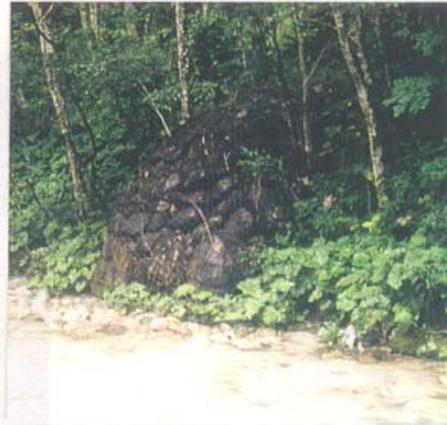
Buhnenkopf einer Drahtschotterbuhne. Die Bereiche zwischen den einzelnen Buhnen sind bereits vollständig verlandet (hm 14,0).
