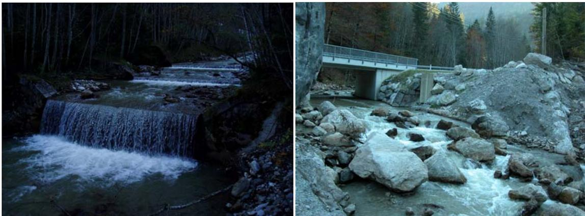
Foto 13, Foto 14: Die klassische Barriere bei hm 36.5 (links). Doch da und dort hat sich die Natur selbst geholfen: Bei hm 47.0 war bis zum Jahr 2002 eine 150cm hohe Betonschwelle. Die mit dem Hochwasser entstandene Blockrampe bei der Silberreith (rechts) ist akzeptabel und muss nur noch optimiert und dauerhaft befestigt werden. - Bilder: Haseke Oktober 2005.
