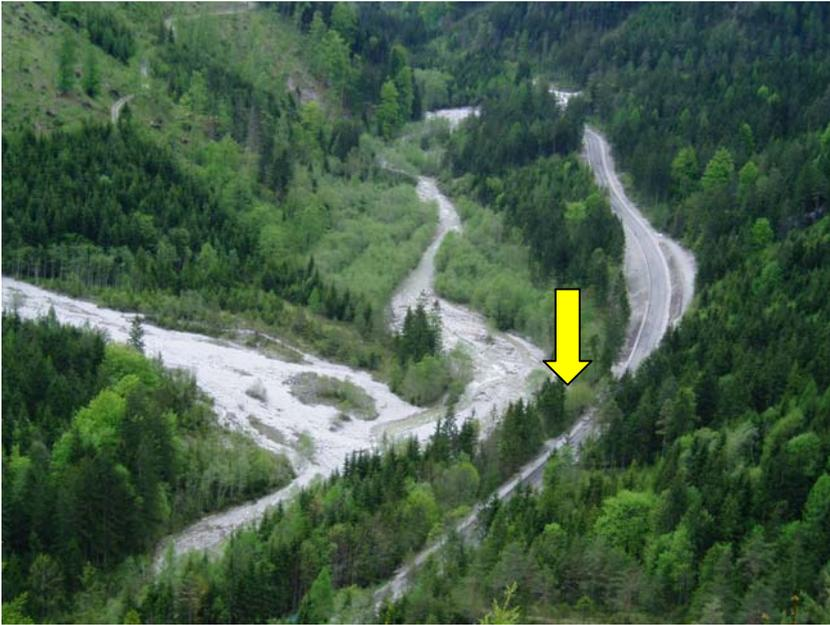
Foto 39: Mündung des Kainzenalbl-Grabens in den Johnsbach, dadurch Abdrängen des Baches zur Straße. Der Pfeil bezeichnet die vorgesehenen Abweisbuhnen. Bild: Haseke, Mai 2006
