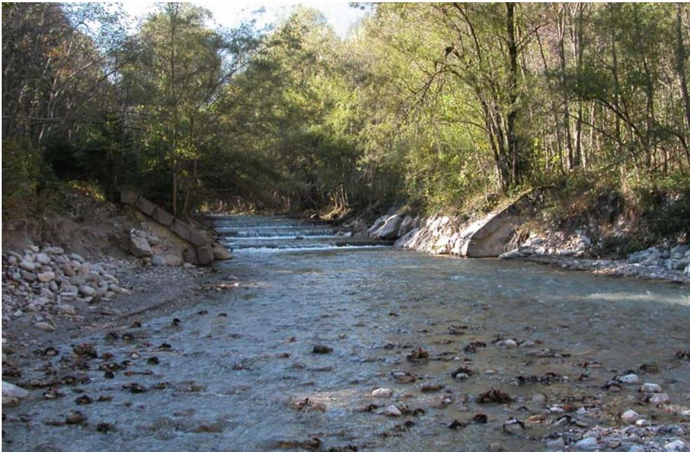
Foto 16: Motiv 0/2, der schwer verbaute Mündungskegel des Johnsbaches. Die Uferpartie links im Bild wird aufgeweitet und soll sich wieder flächig renaturieren. – Bild: Kreiner 10/2005.
