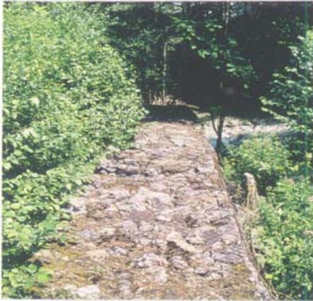
Die massiven Drahtschotterbuhnen reichen größtenteils bis in die Auenzone (hm 37,5).
