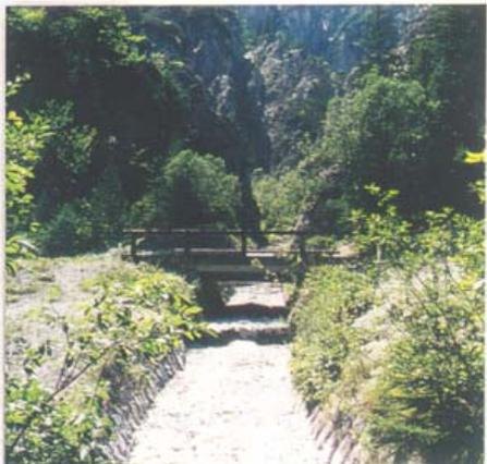
Verbauung des Schwemmkegels eines Seitengrabens bei hm 37,0 (Buckliger Schneider) mittels gemauerter Steinschale.
