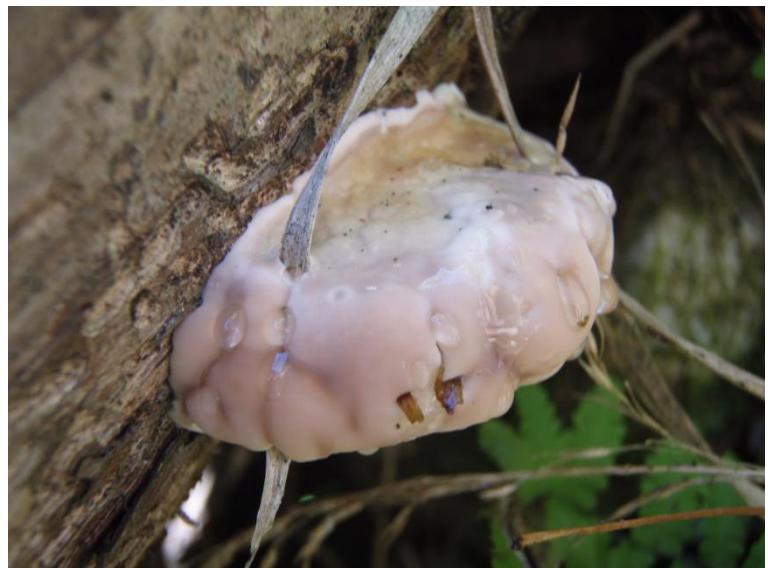
Abbildung 37: Holzabbauender Pilz im Käfernest Nord.
