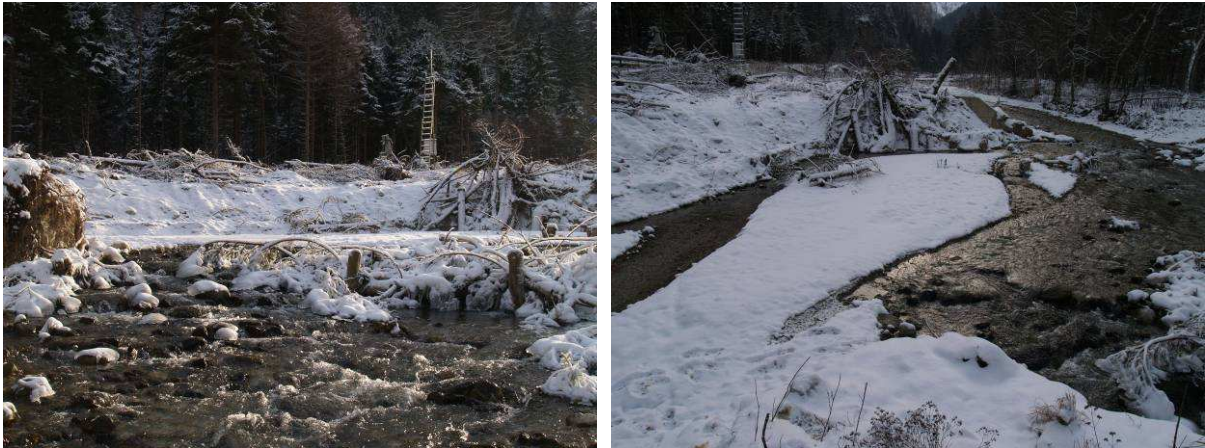
Abb. 15: Schwelle 1.1a: Rechtsufrig neu abgeflachte Rampe (links), Einrinn in Umgehungsgerinne (rechts).
