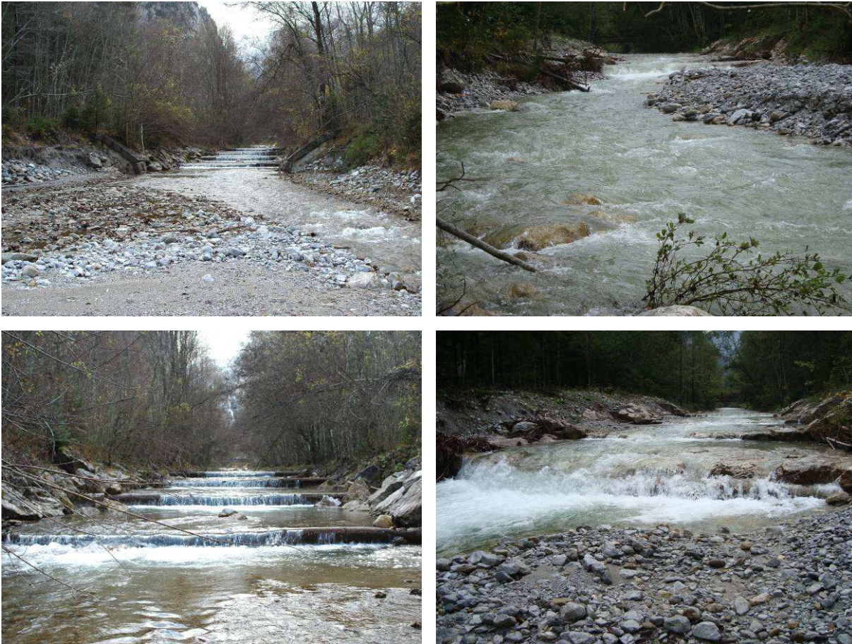
Abb. 6: Abschnitt 1A: Mündung 2005 (oben links, Quelle: Wiesner et al., 2006) und im September 2009 (oben rechts). Abschnitt 1B: Sohlswellen 2005 (unten links, Quelle: Wiesner et al., 2006) und im September 2009 (unten rechts).
