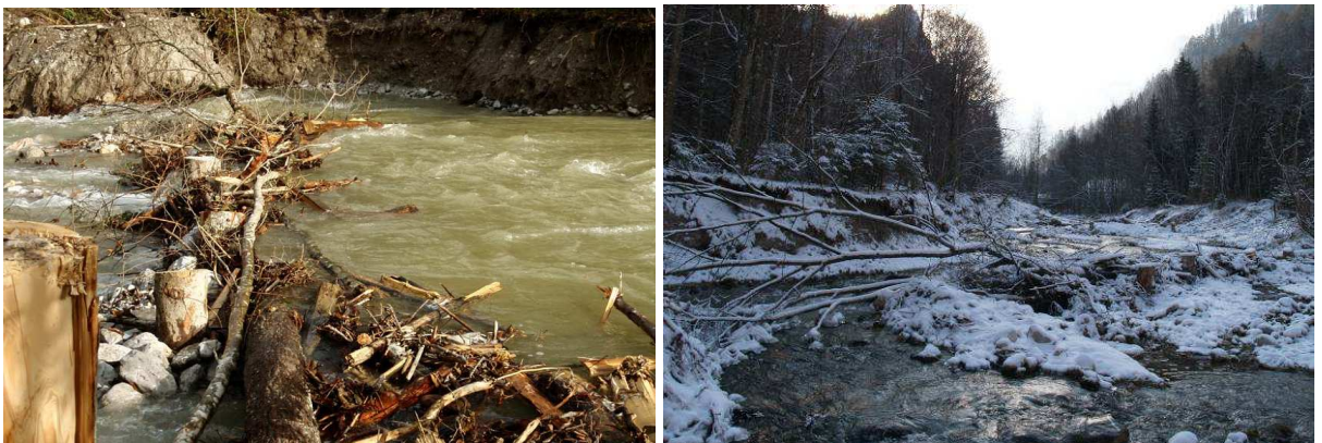
Abb. 9: Raubaumbündel und Schotterbühne im Oktober 2009 (links, Bild: Haseke 2009) und Dezember 2009 (rechts, flussauf).
