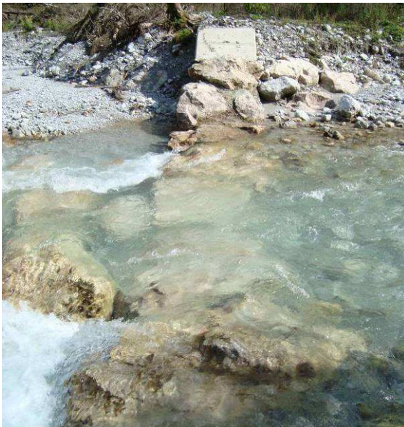
Abb. 11: Restrukturierte Schwellen in Abschnitt 1.1. Schwelle 1.1b (links) und Schwelle 1.1d (rechts).
