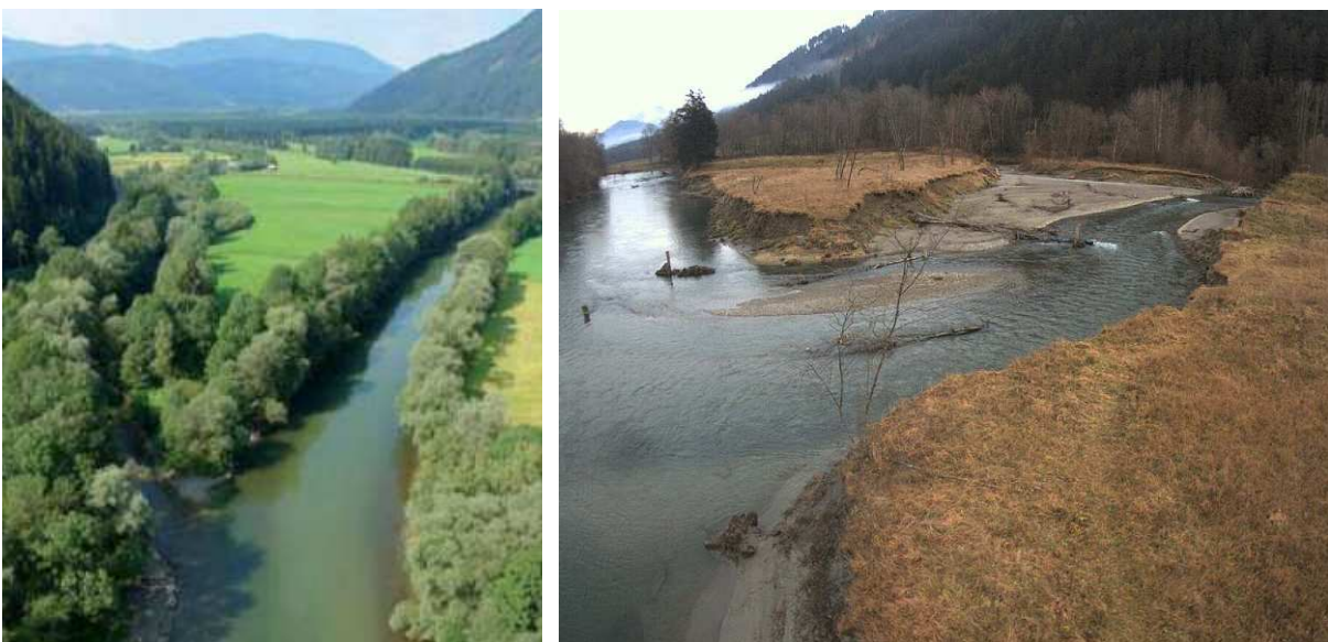
Abb. 28: Paltenmündung vor (links, flussauf) und nach Umbau (rechts, flussab). Quelle: Foto links: www.nationalpark.co.at , Foto rechts: http://zepp-cam.at/palten/index.php (Zugriff am 17.11.2009).
