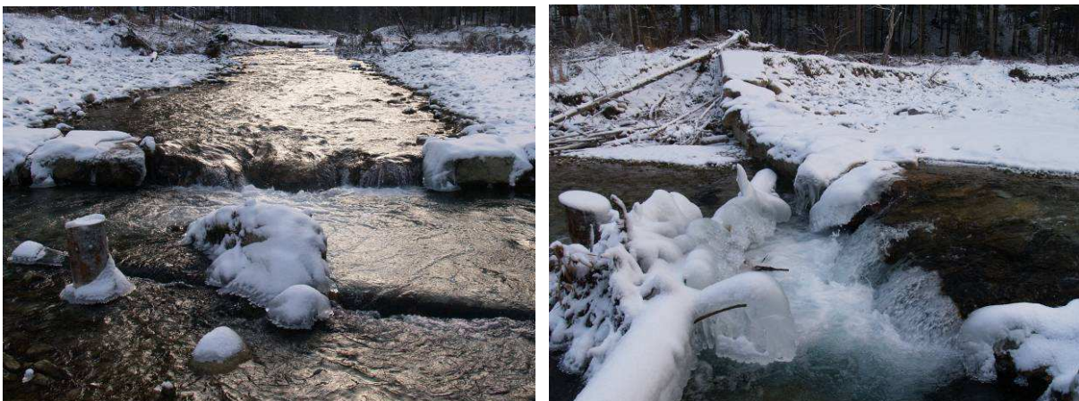
Abb. 16: Schwellen 1.1b (links) und 1.1c (rechts) im Dezember 2009.
