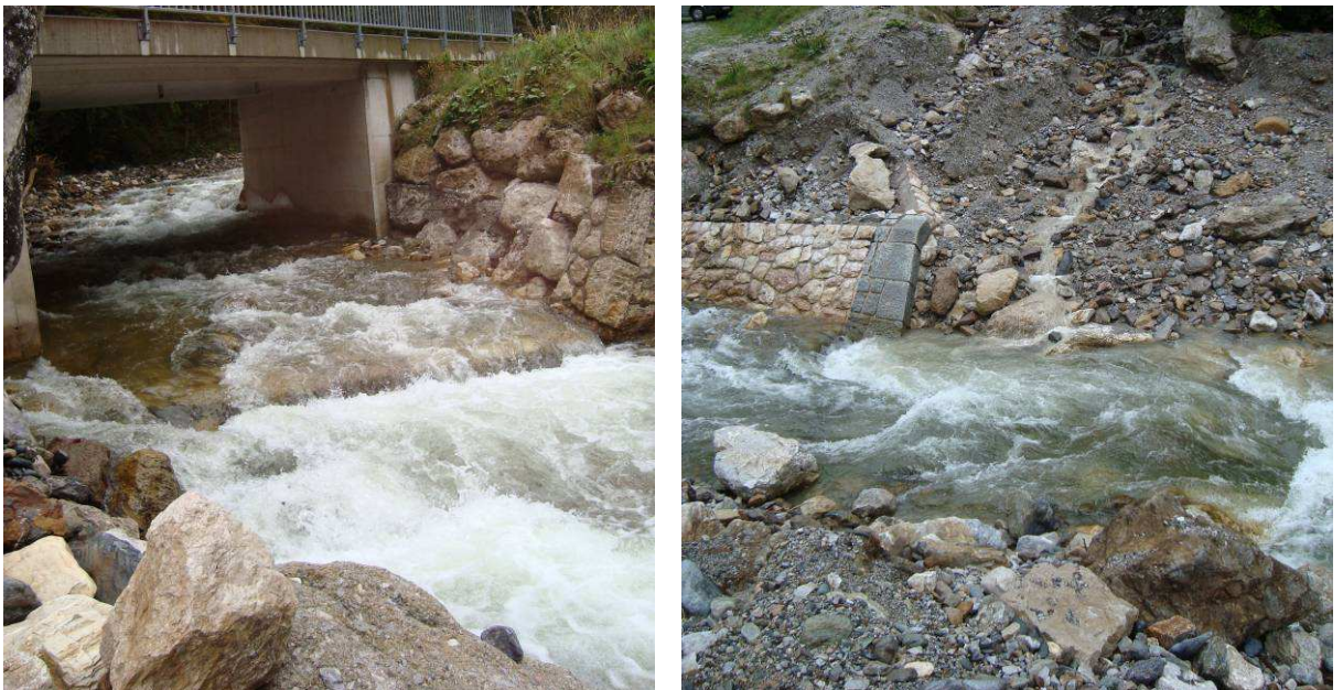
Abb. 24: Schwelle unter Tunnel (links) und Gewässerstabilisierung (rechts) in Abschnitt 3.
