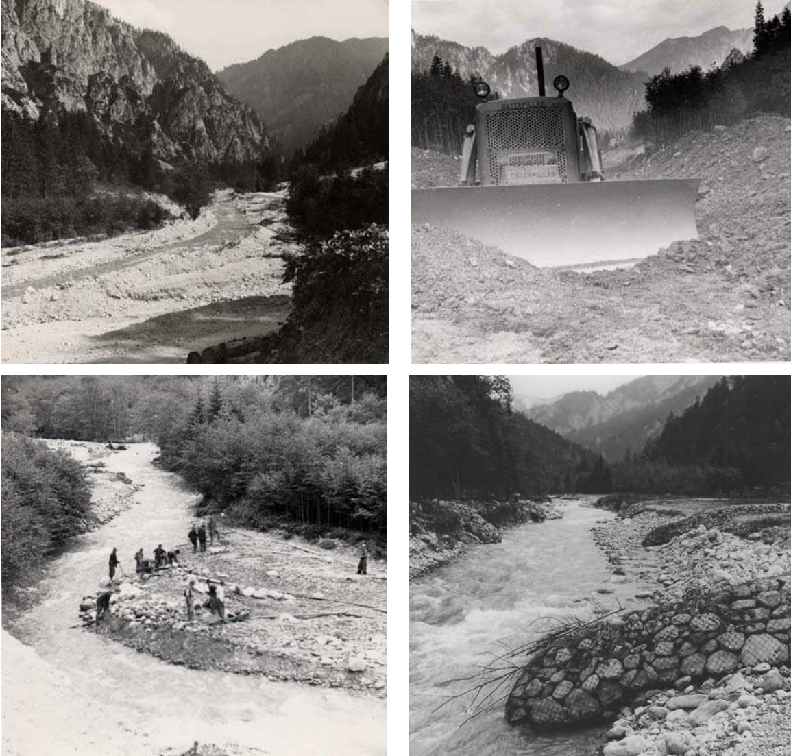
Abb. 4: Bachumlegung in Zwischenmäuerstrecke (oben links), Durchstich mit Caterpillar (oben rechts), Bau einer Bühne (unten links), Bühnenstrecke (unten rechts) (WLV, Gebietsbauleitung Unteres Ennstal und Salzatal, aus Thonhauser, 2007).
