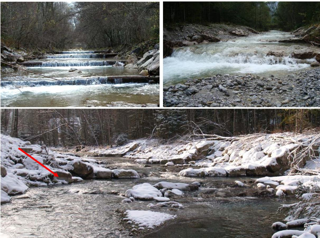
Abb. 3: Mündungsnähe Sohlschwellen (Abschnitt 1B) im Jahr 2005 (oben links), im September 2009 (oben rechts) und im Dezember 2009 (unten, Pfeil signalisiert aufgelöste Ufersicherung).
