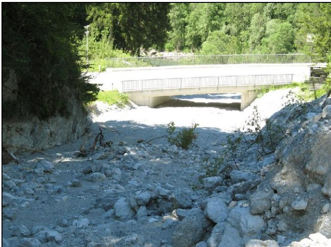
Abb. 2: Bereich direkt oberhalb der Bundesstraßenbrücke, welche ohne Entnahme des Geschiebes regelmäßig verklausen würde. Gut zu erkennen ist der Bereich der Schotterentnahme etwa ab der Bildmitte: Hier fehlt die Geschiebedurchmischung und es liegt ausschließlich Feinschutt vor. Photo: B. Emmerer/STIPA
