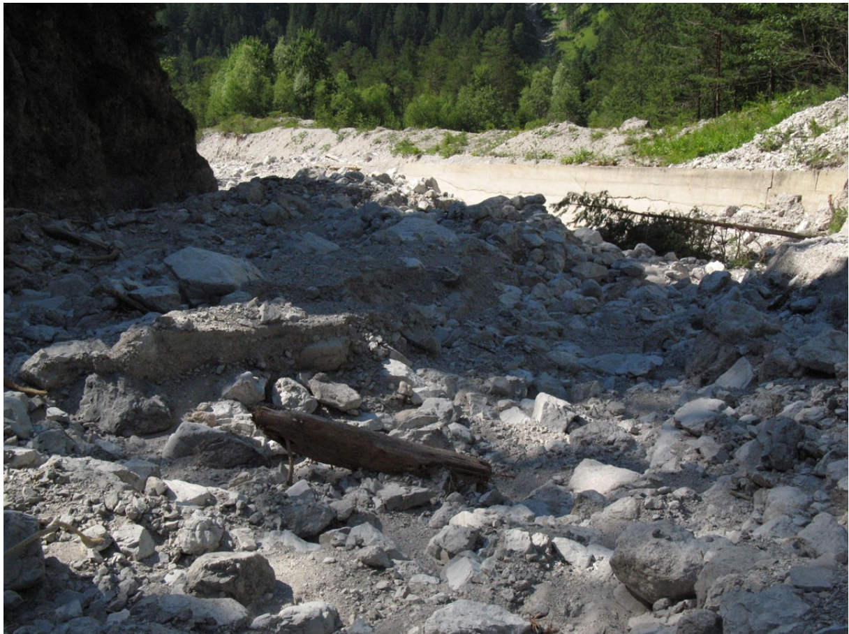
Abb. 19: Altes betoniertes Längsbauwerk zur Umlenkung der Schüttung aus dem namenlosen Seitengraben. Photo: B. Emmerer/STIPA
