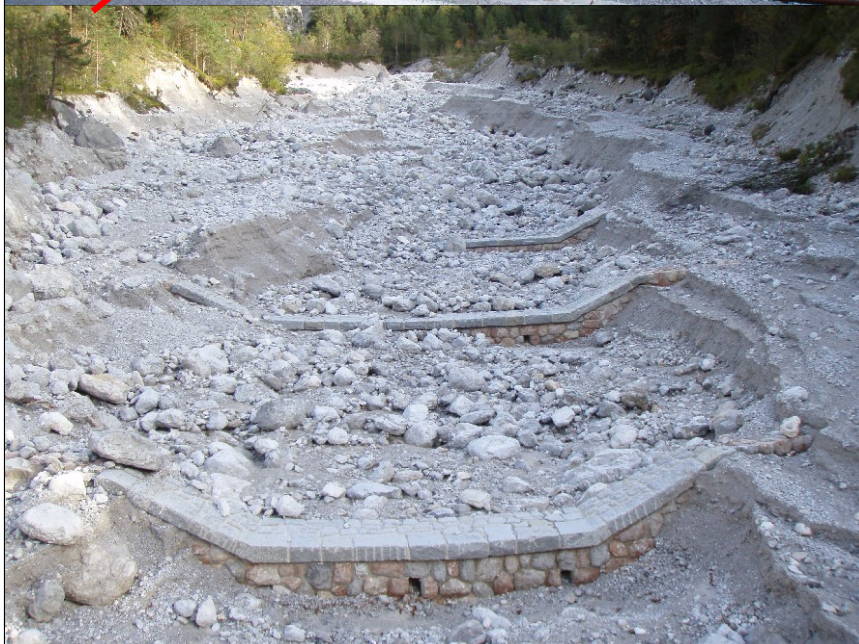
Abb. 16: Haindlkargaben direkt oberhalb der Bundesstraßenbrücke im Jahre 2007.
