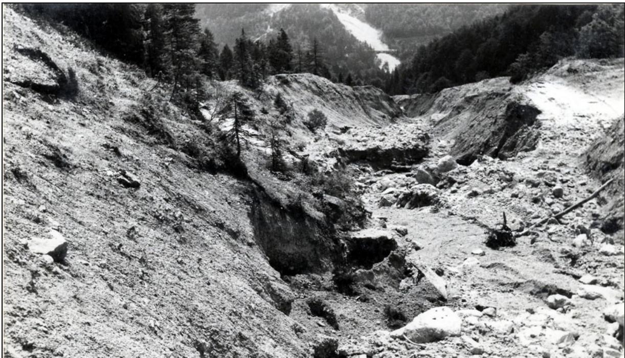
Abb. 20: Mittlerer Bereich Kühgraben im Jahre 1979 nach Murenabgang, Querung der Forststraße (helle Bereiche links und rechts oberhalb der Bildmitte) bei Kote 944. Blickrichtung ins Tal, gegenüber der Handkargraben. Die Mure hat den Kühgraben hier bis 8 m vertieft. Bildquelle: WLV
