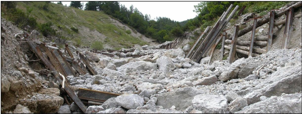
Abb. 5: Massive, bereits wieder deutlich in Mitleidenschaft gezogene Stahlträgerkonstruktionen als Verbauungen am oberen Kühgraben, links im Hintergrund ingenieurbioologische Sicherungsmaßnahme. Photo: H. Kammerer/STIPA
