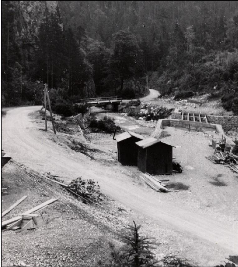
*Abb. 17: Neuanlage der Straßenbrücke über den Johnsbach im Bereich der Mündung des Kaderalbschüttgrabens. Ansicht aus 1951(?). Photo: WLV*
