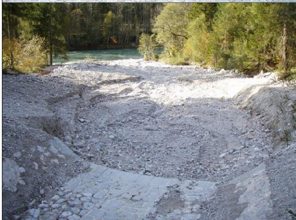
Abb. 19. Situation 2007: Der Graben wurde im Spätsommer 2006 ausgebaggert und das Schmelzwasser im Frühjahr 2007 hat das verbleibende Geschiebe abtransportiert. So ist wieder das Trapezprofil der Brückenverbauung sichtbar geworden.
