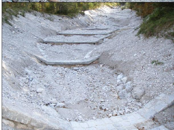
Abb. 15. Situation 2007: Der Graben wurde im Spätsommer 2006 ausgebaggert und das Schmelzwasser im Frühjahr 2007 hat das verbleibende Geschiebe abtransportiert. So sind wieder die Querverbauungen sichtbar geworden. Photo: D. Kreiner/NP Gesäuse.
