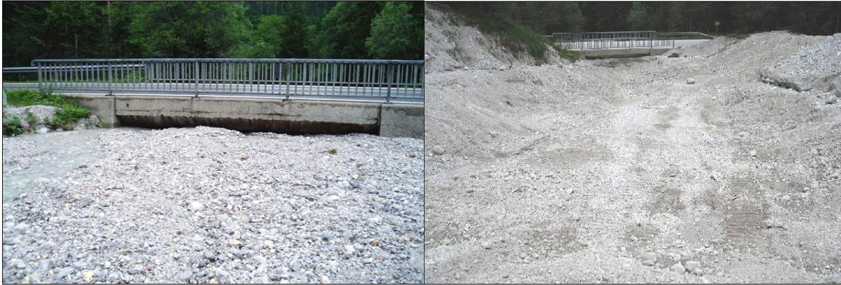
Abb. 16. Situation 2006: Bundesstraßenbrücke von Süden aus gesehen. Das Bedrohungsszenario für die Brücke ist deutlich sichtbar. Links vor, rechts nach der Schotterentnahme. Photo: D. Kreiner/NP Gesäuse (links) B. Emmerer/STIPA (rechts)
