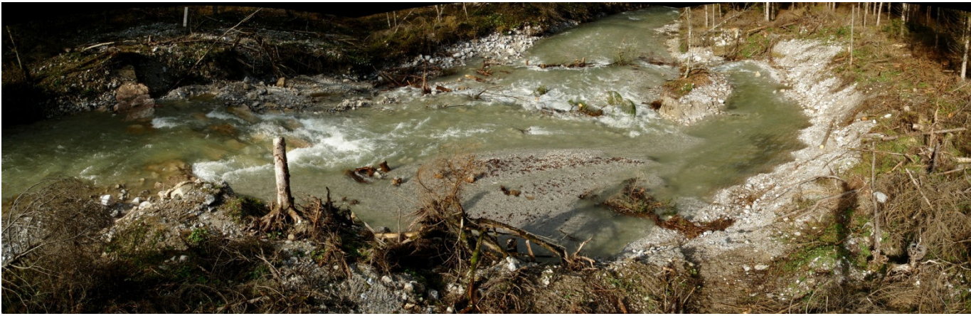
Webcamstufe hm 5: Zweite Umgestaltung, „Lenkbühnen“ aus Bäumen . - Foto: Haseke 23.10.2009
