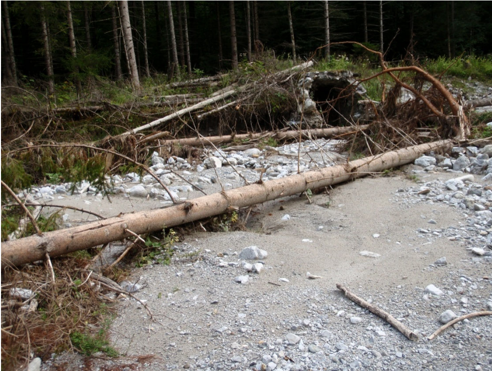
Webcamstufe hm 5, erodierter Rest einer Gabione (Querverbau) und Totholzanlandung im Strömungsschatten am rechten Ufer. - Foto: Haseke 3.9.2012
