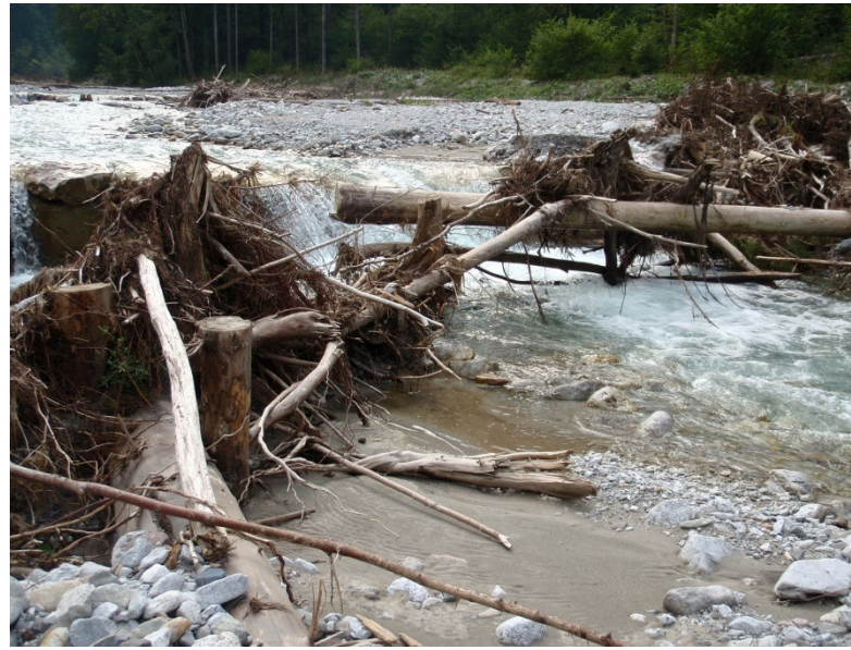
Grundschwelle und Problemstufe hm 6, Holzanlandungen nach dem Julihochwasser 2012.
