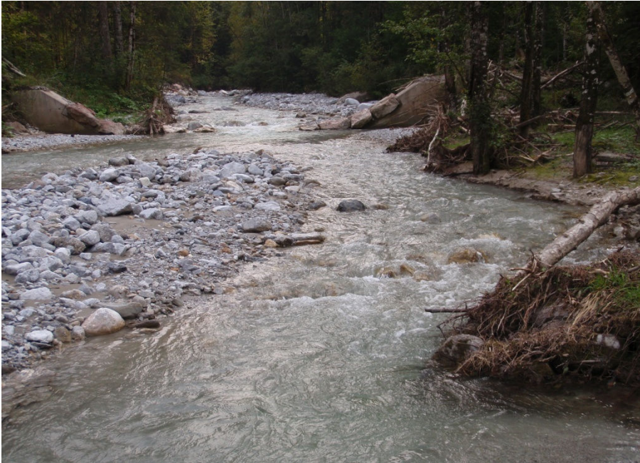
Letzte Schwelle vor der Gseingmündung hm 15-16.
