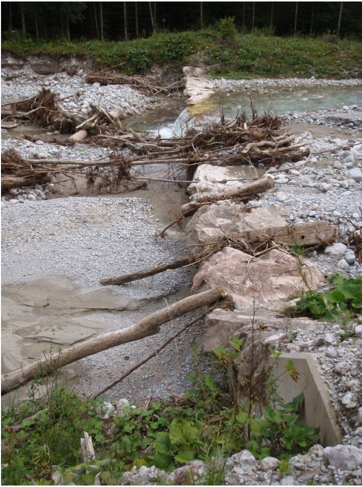
Grundschwelle und Problemstufe hm 6, Holzanlandungen nach dem Julihochwasser 2012.
