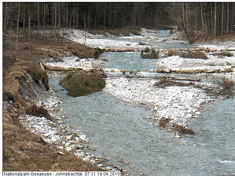
Einbau weiterer Bremsbäume, Situation am 19.4.2010 7:11
