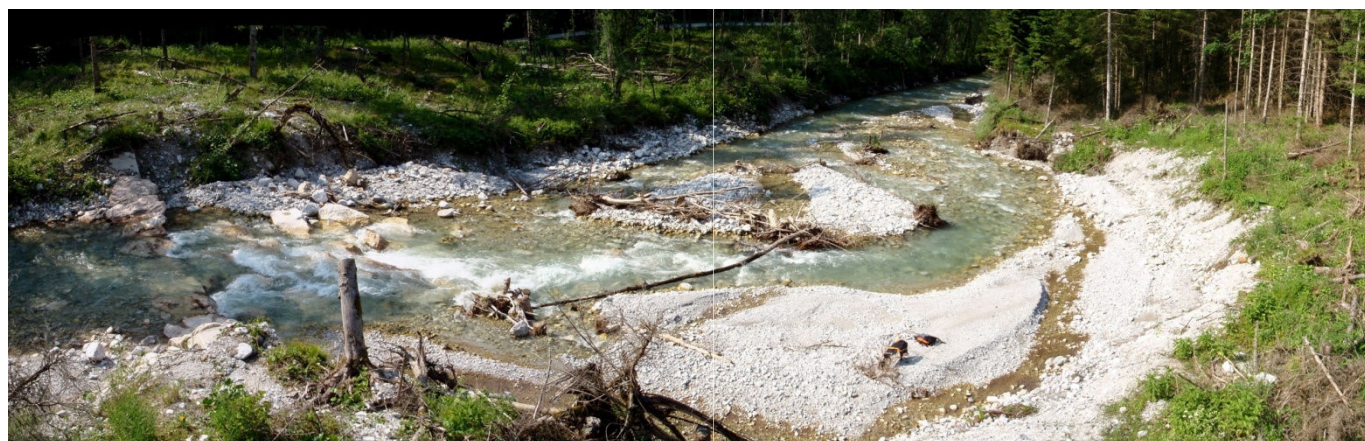
Webcamstufe hm 5: Aufschotterung und Ablenkung an den Schrägbäumen. - Foto: Haseke 1.7.2010
