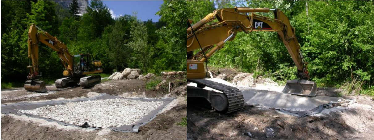
Abb. 37: Einbringen einer unteren Lage an grobkörnigerem Material (Grobsschotter, Korngröße 80+) und darüber einer feinkörnigeren Lage (Feinschotter, Korngröße 20+).
