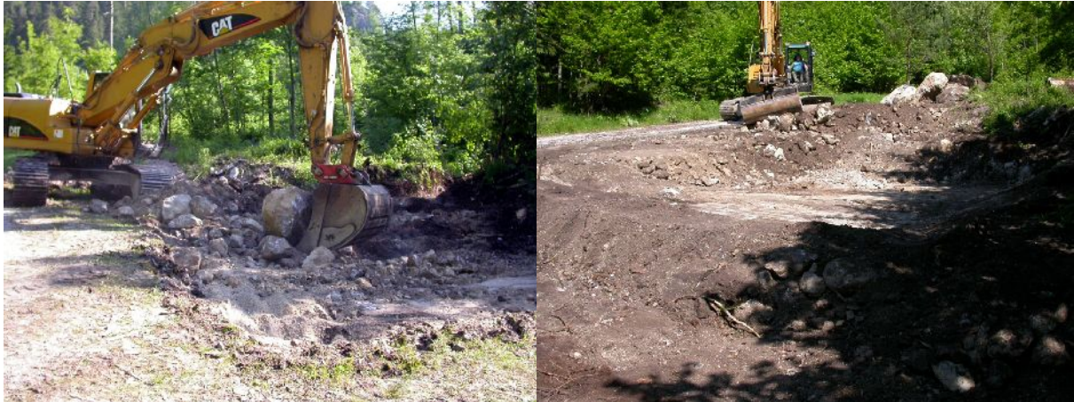
Abb. 34: Aushub einer Fläche von etwa 80 m 2 und Errichtung eines Beckens durch Schaffung eines Walls am unteren Ende des zukünftigen Pflanzgartens.
