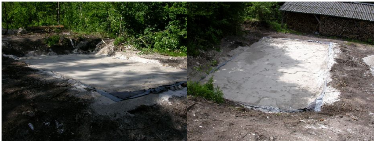
Abb. 38: Fertigstellung des Schotterkörpers durch Aufbringen einer feinkörnigen Abschlusslage (Korngröße 5-10).
