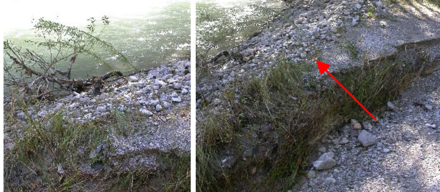
Abb. 55: Standort Reicherlboden Nr. 2 (23.09.2007)
