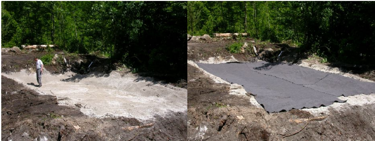
Abb. 35: Das Becken wurde mit Schotter feiner Körnung ausgekleidet und darauf ein Geotextil ausgebreitet, um eine Beschädigung der nächsten Schicht, der Teichfolie, zu vermeiden.
