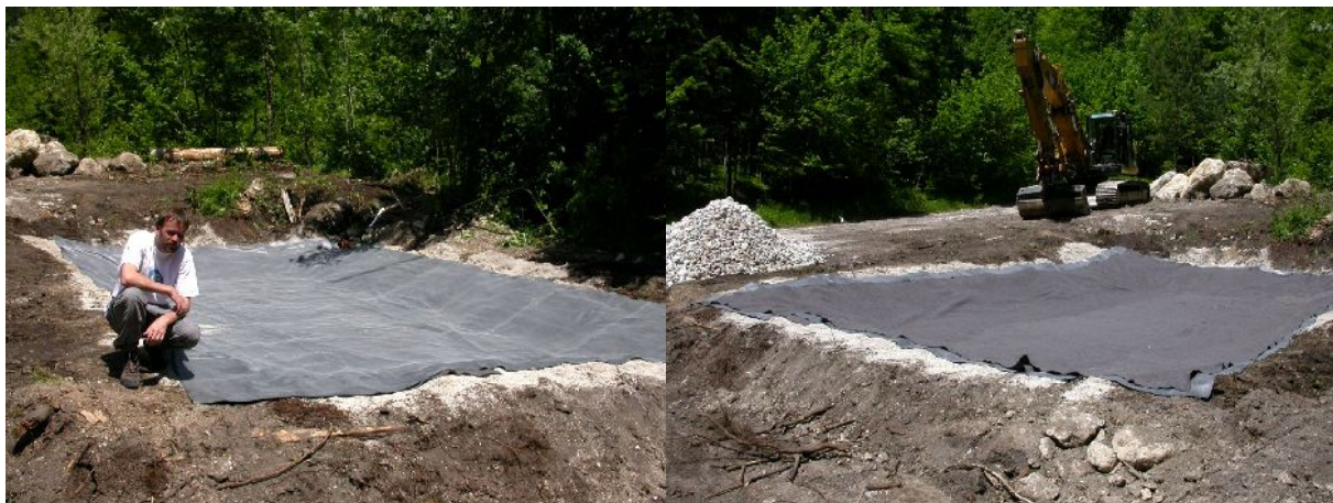
Abb. 36: Auslegen der Teichfolie und darauf eine weitere Lage Geotextil, um die Teichfolie auch nach oben hin zu schützen
