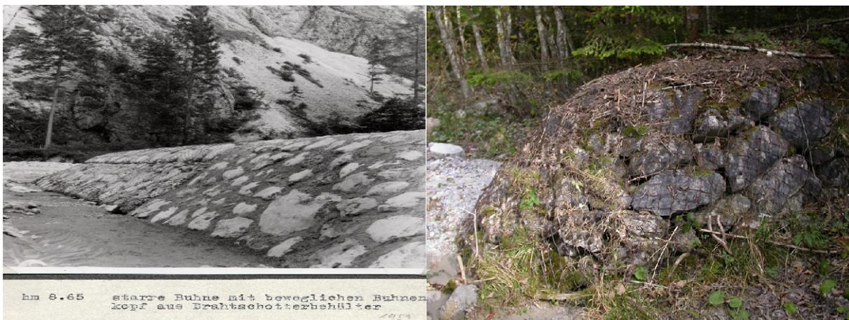
Abb. 11: Bühnenstruktur mit gemauertem "Körper" und beweglichem Kopf als Drahtschotterbühne (1951) und Ansicht aus dem Jahre 2005. Photos: WLV (links), STIPA (rechts)
