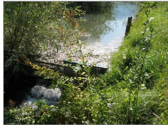
Abb. 4.2.10: Abflusssituation an der Brücke
