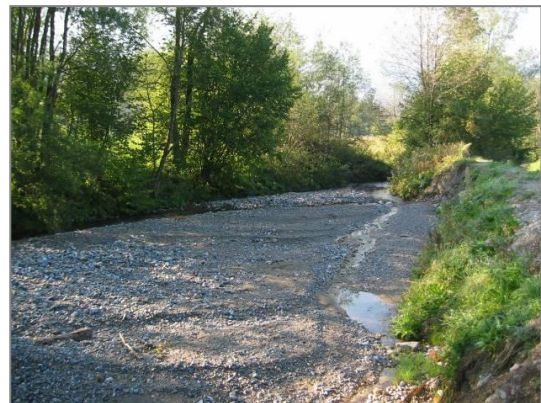
Abb. 4.7.7: Ausschotterung des Rabengrabenbaches hinter dem neu errichteten Damm, 2006
