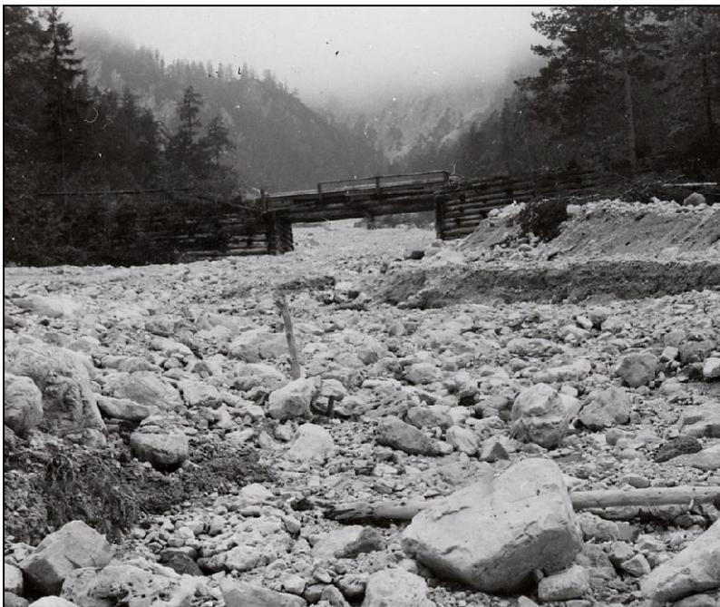
Abb. 12: Mündungsbereich des Langgriesgrabens samt Landesstraßenbrücke im Jahre 1951. Der genaue Blick unter der Brücke hindurch belegt, dass der Graben gegenüber seinen Rändern noch kaum eingetieft war. (Photoquelle: WLV)
