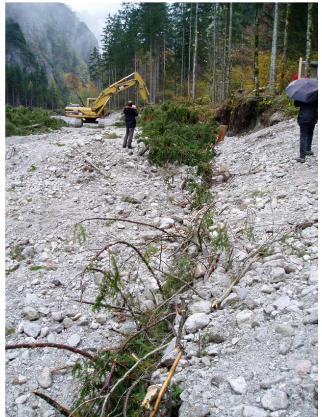
Bilder links oben und unten: Im Besucherbereich bei den hohen Schwellen einpilotierte Bäume, die erfolgreich als Schotterfang dienen (2010), links ein „Raubbaum“ zur Böschungsfestigung (2006)
