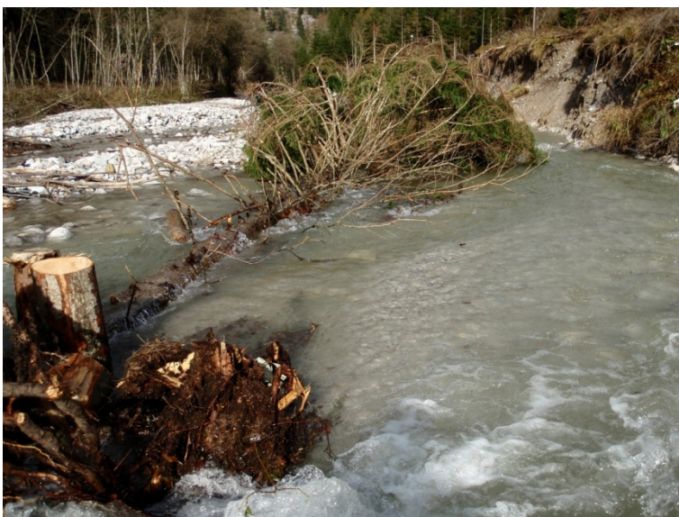
Bilder links oben und unten: Im Besucherbereich bei den hohen Schwellen einpilotierte Bäume, die erfolgreich als Schotterfang dienen (2010), links ein „Raubbaum“ zur Böschungsfestigung (2006)
