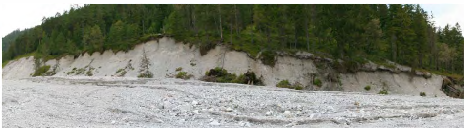
Figure A.3.7: Die übersteilte Böschung an der orographisch linken Seite des Langgriesgrabens ist massiv von Erosion betroffen (Foto: S. Schöttl).
