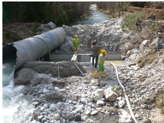
Figure A.1.3: Mitarbeiter der BOKU und der WLV bauen im März 2014 die Geschiebefalle mit vorgelagerter Geophonanlage in Höhe des Gasthofes zur Bachbrücke ein.
