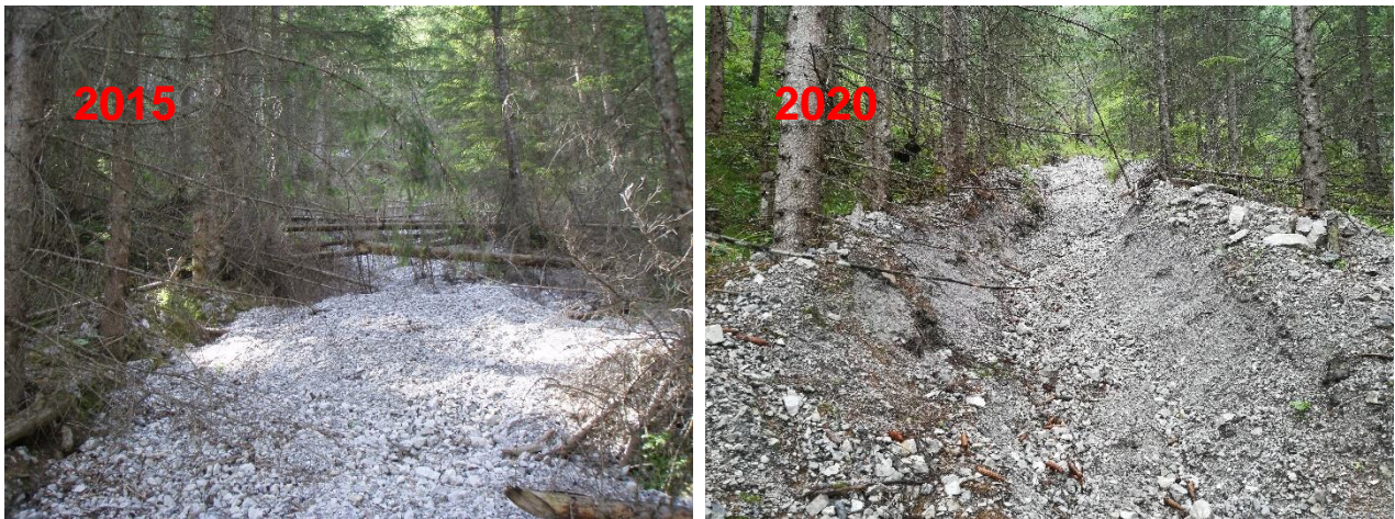
Abbildung 5 – Beispiel fur Eintiefung einer Erosionsrinne durch Auswaschung/Abtrag von Schottermaterial durch ein Erosionsereignis (Rinne Nr. 5)
