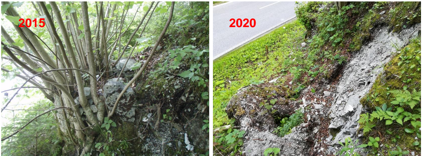
Abbildung 8 - Entwurzelung eines Haselstrauchs bei Erosionsrinne 21
