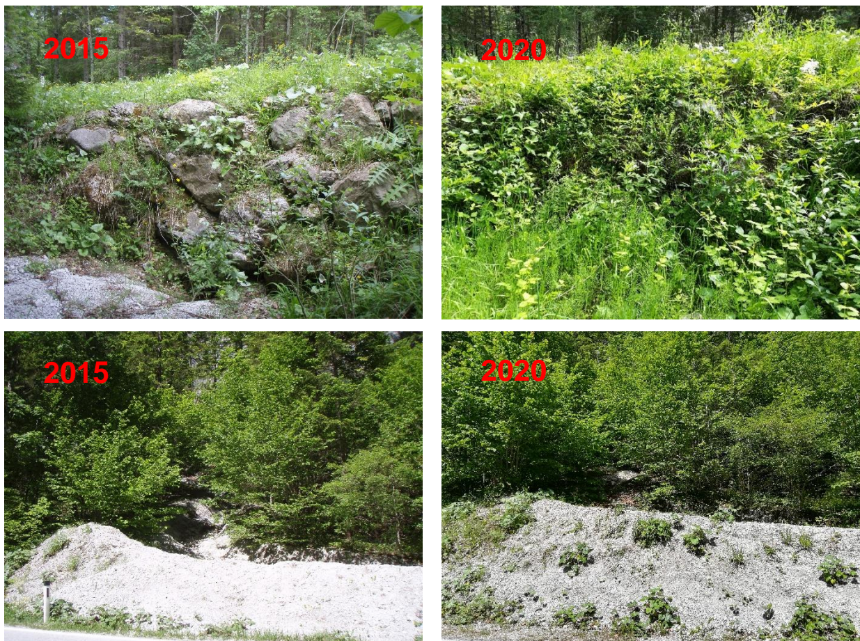
Abbildung 3 - Beispiel fur Bewuchs von Befestigungsanlagen (oben bei Erosionsrinne 23) bzw. von Schutthaufen (unten bei Erosionsrinne 2)
