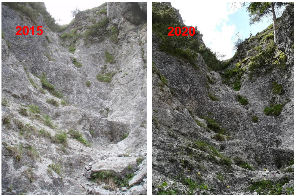
Abbildung 11 - Oberer Bereich der Erosionsrinne 15
