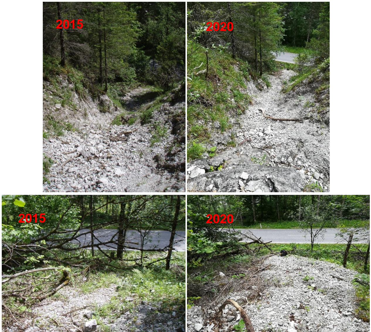
Abbildung 6 - Abbildung des Ergebnisses einer Hangrutschung bei Erosionsrinne 12
