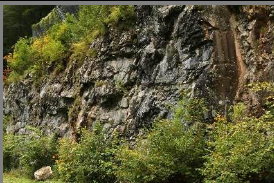
Abbildung 21: Ennsufer auf Höhe der Scheibenbrücke_28-9-2019_P12. [Foto: Ch. Komposch/ ÖKOTEAM, Sept. 2019]
