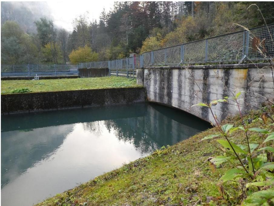
Abb. 6 Am Einlauf des Triebwasserkanales existiert zurzeit keine Rechenanlage.
