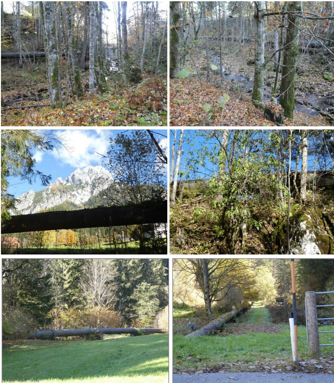
Abb. 4 Bilder der, laut Bescheid bzw. Projektantrag unterirdisch mit einem Meter Überdeckung zu verlegenden Druckrohrleitung.
