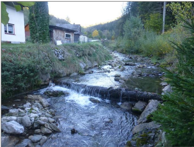
Abb. 1 Typische Holzschwelle im regulierten Bachbett in der Probestrecke 5 – „Schilift“:
