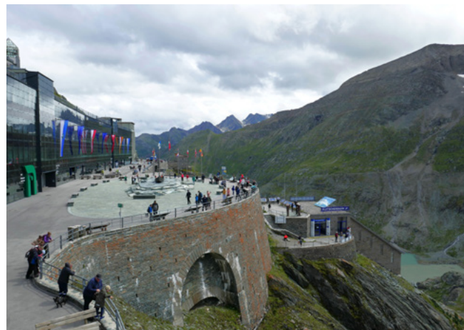
Das in den Steilhang hineingebaute Parkhaus ist das größte Bauwerk im Bereich der Franz-Josefs-Höhe – seit den späten 2010er-Jahren wird an der verglasten Fassade auch Solarstrom erzeugt.
