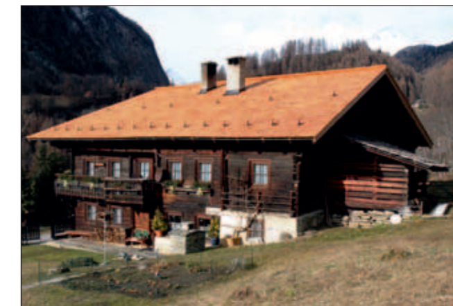
Holzdacheindeckung eines Hauses in Heiligenblut.
