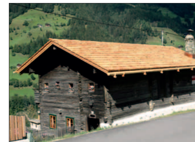
Holzdacheindeckung eines Hauses in Großkirchheim.
