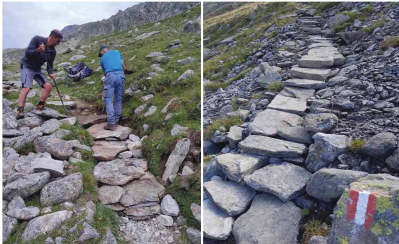
(1) Wegarbeiter des ÖAV Matrie beim Tausch der schweren Steinplatten. Um die Natur und den ursprünglichen Wegverlauf erhalten zu können, geschah die Renovierung in Handarbeit. (2) Wegabschnitt nach der Sanierung. © Stefan Lerch
