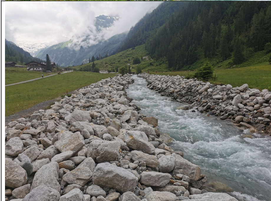
Mit Dammbau- werken gesi- cherte Ufer zum Schutz vor Aus- uferung unter- halb der Enzian- hütte
