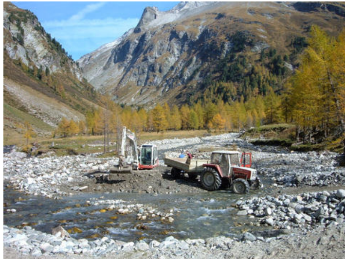
Abb.2: Baggerungsarbeiten im Bereich der Einmündung Laperwitzbach.
