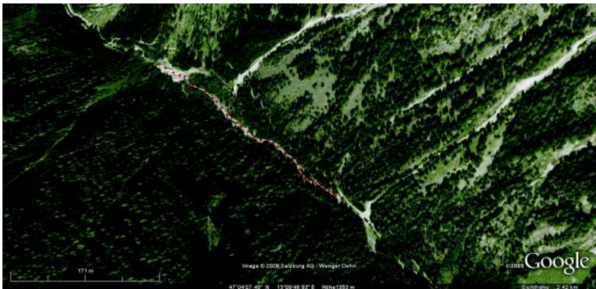
Abbildung 2: Von Brücke bis zur großen Geschiebesperre ca.550 m.
