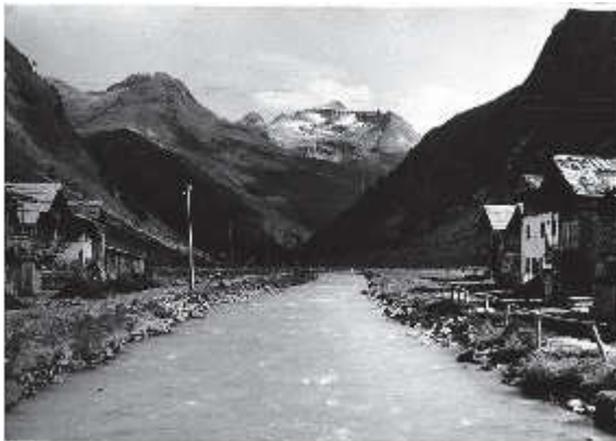
Abbildung 3.11: Fotoaufnahme nach Fertigstellung der Regulierungsmaßnahmen (Archiv Fotoalbum Baubezirksamt Lienz)
