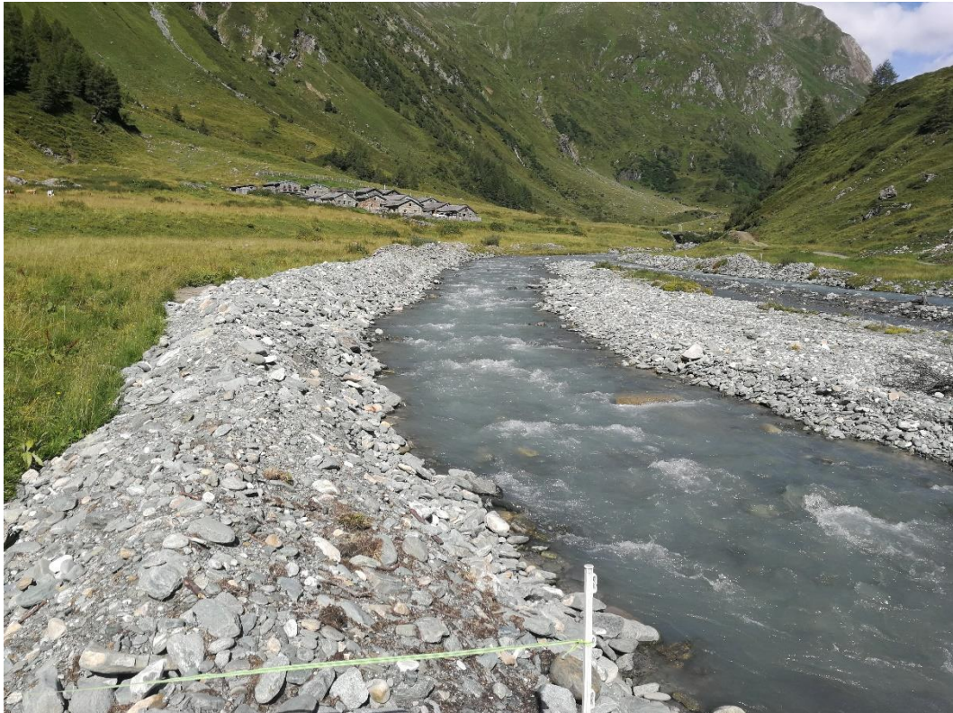
Abb. 24: Steindamm am orografisch rechten Ufer (im Bild links) sowie (im Hintergrund rechts erkennbar) am orografisch linken Ufer. Eigene Darstellung, 2024.
