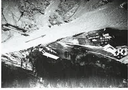
Abb. 2.5: Hopfgarten, August 1966. Rechts im Hintergrund der Zwenewaldbach. Beim Ereignis im August 1966 brach die Schwarzach vor allem rechtsufrig aus, während es beim Ereignis 1965 durch den massiven Einstoß des Zwenewaldabaches vor allem linksufrig zu großflächigen Überflutungen kam.
