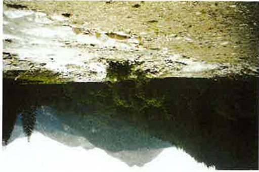
Abb. 2.35: Geschiebeablagerungsplatz Ers- bach. Als Folge der Baggerungen nach dem Ereignis 1991 ist das Profil in der Lage, gro- ße Geschiebemengen zu transportieren. Erst bei großen Ereignissen ist mit Anlandungen zu rechnen.
