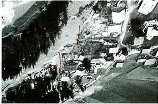
Abb. 3.1: Mariahilf beim Ereignis 1965. Die Schwarzach brach bei auftrag aus. Auch heute noch besteht bei 100-jährlichen Ereignissen akute Überschwemmungsgefahr.
