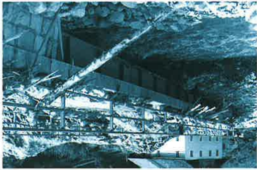
Abb. 3.5: Verklänsungen von Brücken waren bei den Hochwasserereignissen 1965/66 häufig die Ursache für Bachverwerfungen und folgenschwere Schäden im Umland.
