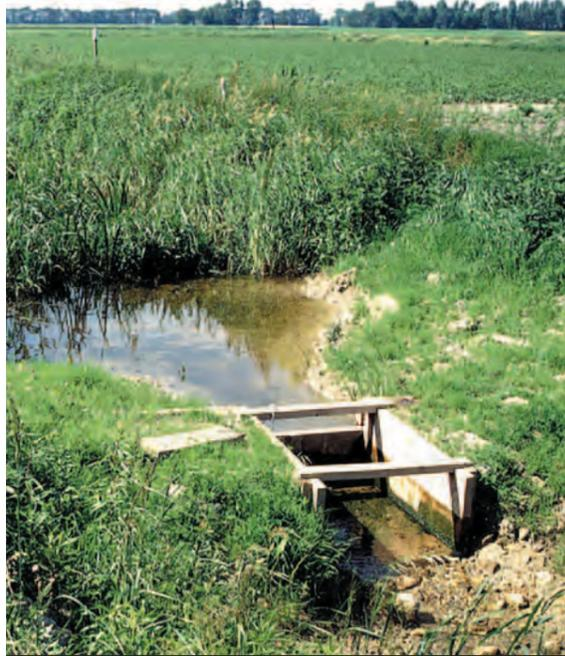
Eine durch den Nationalpark errichtete Rückstaukonstruktion in einem alten Entwässerungsgraben.
