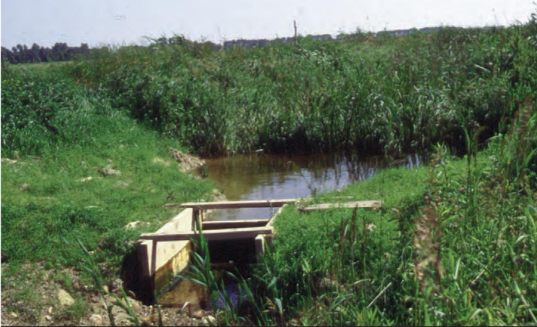
Einsetzkästen in alten Entwässerungsgräben ermöglichen das Rückstauen des Oberflächenwassers in den angrenzenden Wiesen.
