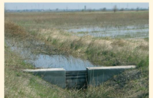
In den Zitzmannsdorfer Wiesen wird seit 1997 durch Schleusen in Drainagierungskanälen Niederschlagswasser rückgestaut.
