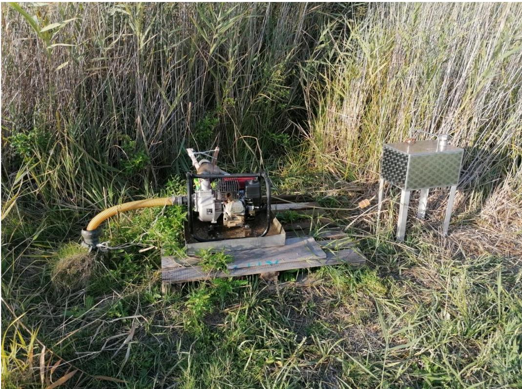
*Abb.7: Pumpanlage mit Wasserzähler zur Erfassung der gepumpten Mengen in die Götschlacke*
