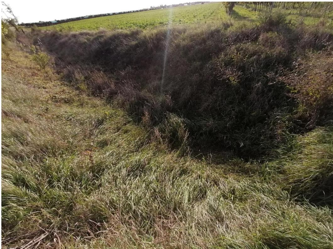
*Abb.12: Messstelle im „Abflussgraben“ der Moschatolacke (verwachsen und führt kein Wasser)*
