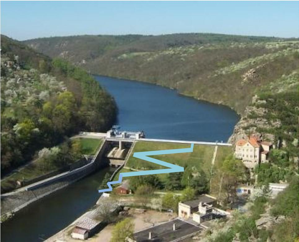
Abb. 6: Kraftwerk Znaim: möglicher Fischaufstieg „technischer Schlitzpass“ (genügend Platz vorhanden)
