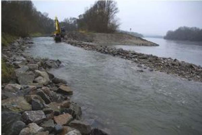
Abbildung 20: Asymmetrisches Raugerinne mit Kolk-Furt-Abfolgen und Rauigkeitselementen entlang der Tiefenrinne am Beispiel der Mündung des Mitterwassers in die Donau bei Asten (ZAUNER ET AL. 2010).
