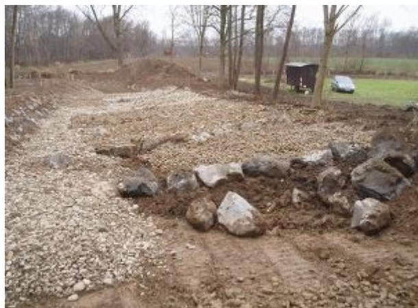
Abbildung 17: Aufbau der asymmetrischen Gerinnesohle aus Querriegeln und grobem Kies (Gerinne ohne Hochwasserbelastung). Beispiel Ruppühle bei Halbenrain an der Mur (ZAUNER & MÜHLBAUER, 2007)
