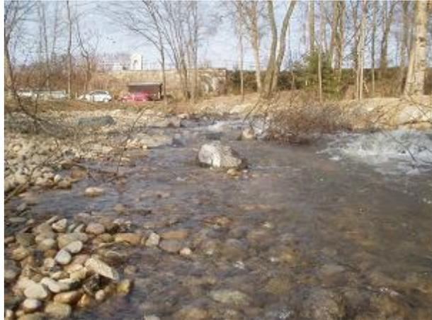
Abbildung 16: Verzahntes, strömungsberuhigtes Flachufer einer asymmetrischen Rampe am Beispiel Ruppühle bei Halbenrain an der Mur (ZAUNER & MÜHLBAUER, 2007).
