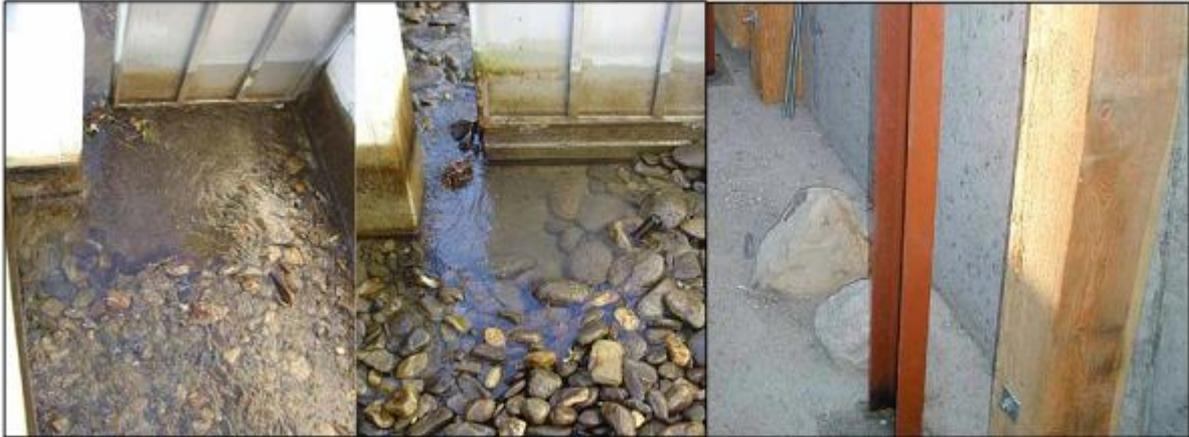
Abb. 3: Unerwünschte Geschiebebewegung im Schlitzbereich eines Schlitzpasses führt zu einer Beeinträchtigung der Funktionalität vor allem für bodenorientierte Arten und geänderten Fließgeschwindigkeitsbedingungen durch den Verlust von Rauzigkeit (links) (Wiesner et al., 2007); Einbau fixer Strukturen, um diese Geschiebebewegungen zu vermeiden (rechts) (Gumpinger & Siligato, 2005).
