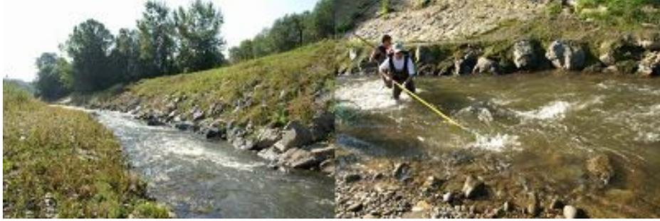
Abbildung 18: Asymmetrisches Raugerinne im Hochwasserabflussbereich mit Sohle aus Wasserbausteinen und Kies am Beispiel der Gamlitzbach-Mündungsrampe (ZAUNER ET AL. 2009).
