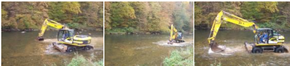
Abb. 1-3: Schaffung des künstlichen Laichplatzes 1
