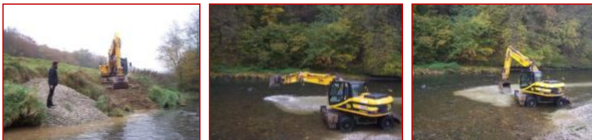
Abb. 5-7: Baumaßnahmen am künstlichen Laichplatz 2
