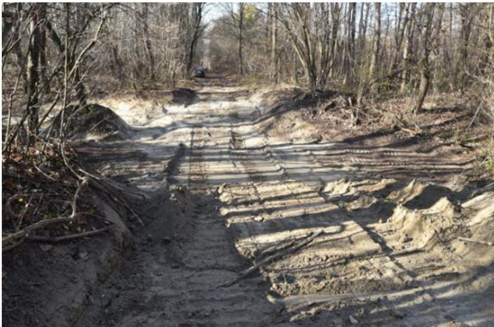
Abbildung 107: Grabenrückbau des östlichen Grabens kurz vor Fertigstellung (Blickrichtung Ost-West)
