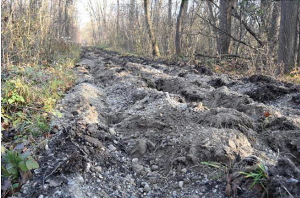
Abbildung 103: Teilabschnitt der durch den Reißzahn aufgerissenen Forststraße
