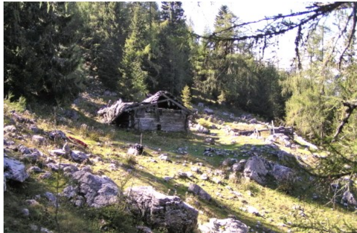
Abb. 76: Zinödlalm mit verfallenen Almgebäuden.
