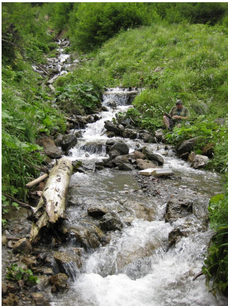
Foto 44: Grob verblockter Bach im unteren Faschinggraben vor der Geschiebesperre. - Bild: C. Remschak, 20.7.2016
