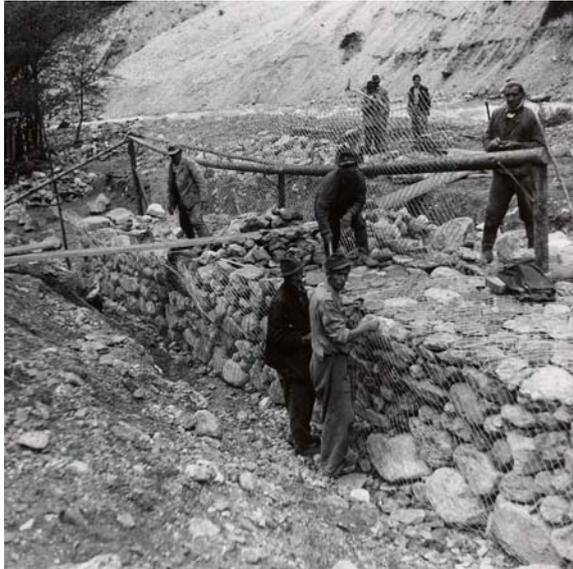
Abbildung 10: Drahtschotterleitwerk 1
