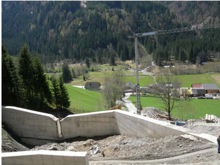
Abbildung 43: Huberhausgraben, Geschiebedosierwerk
