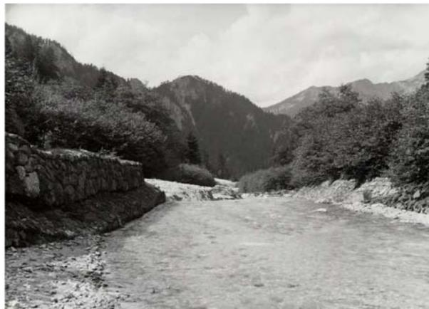
Abbildung 21: Zwischenmüer Leitwerk
