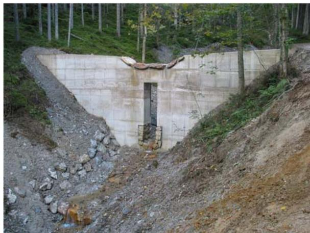
Abbildung 46: Scheibengraben, Stahlbetonsperre
