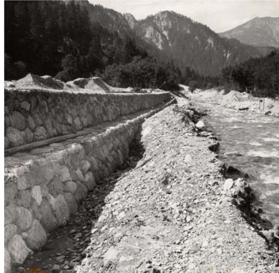
Abbildung 11: Drahtschotterleitwerk 2
