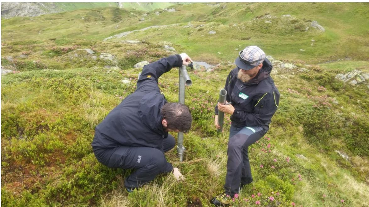
**Abbildung 9: Eindrehen eines Erdnagels mit einem Drehschlüssel (aus dem Wanderwegebau) und Eisenrundprofilstange (rechts in der Hand des NP MA); Kamera I4**
