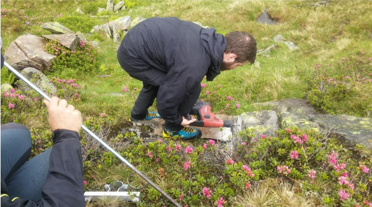
**Abbildung 11: Erstellen eines Bohrloches in einem Stein, in welchem die Gewindestange verankert wird; Kamera I5**
