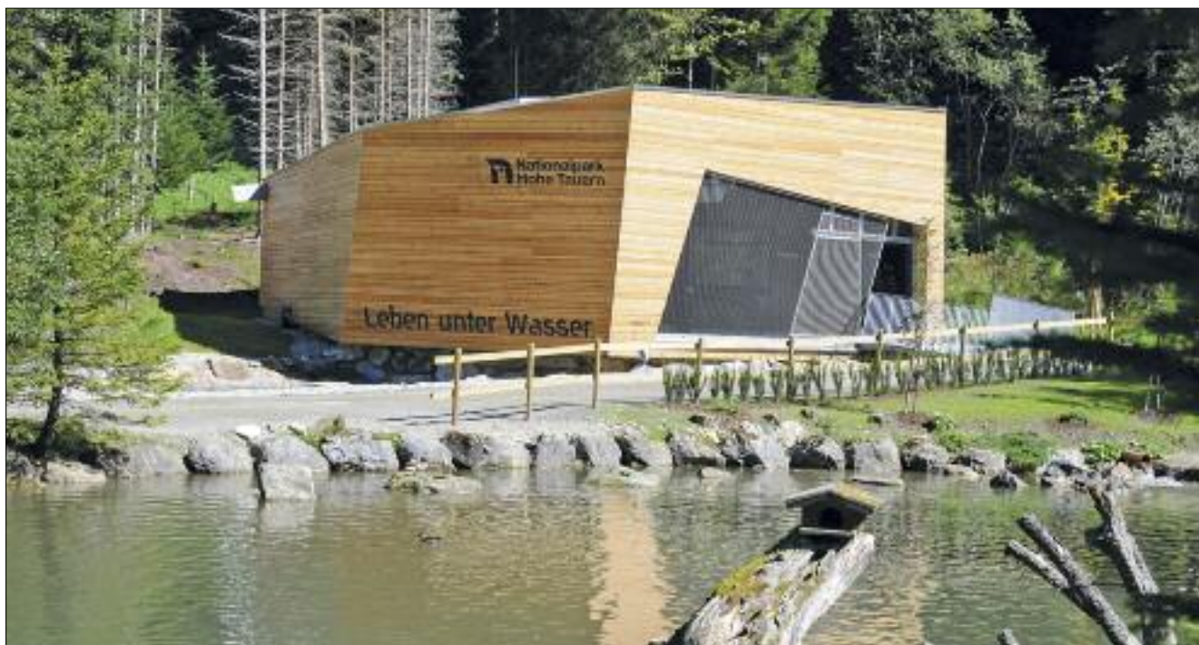
Der Vorplatz des Pavillons dient als verbindendes Element zwischen Wassereinrichtungen im Wildpark und der Ausstellung. Der direkt am und teilweise unter dem Haus fließende Spielbach ist vor allem für Kinder eine willkommene Abwechslung.
