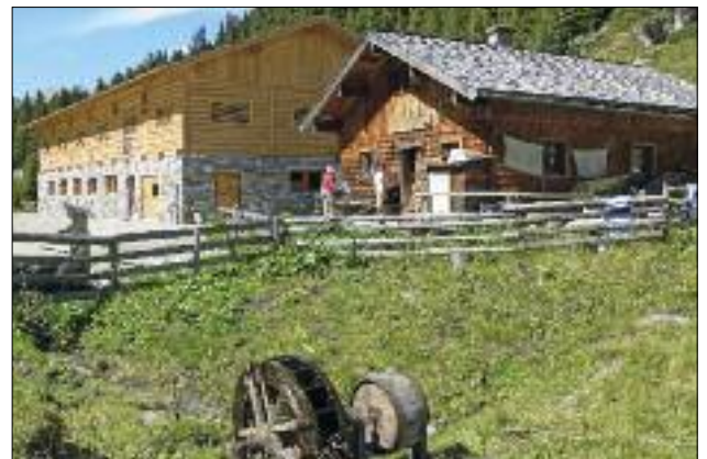
Neubau eines Almstalls für zeitgemäße Ansprüche im bodenständigen Baustil
